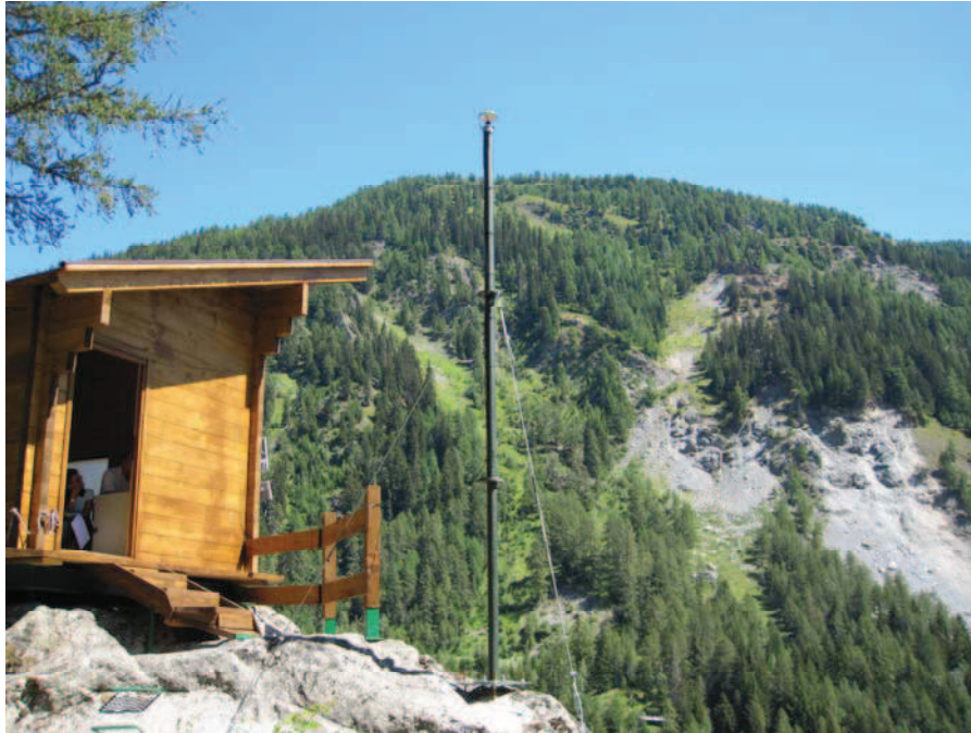
Foto 3: Vista della stazione GPS automatica di riferimento.
