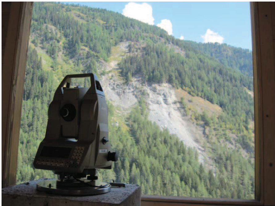
Foto 4: Teodolite motorizzato TCA2003 installato sul pilastro all'interno dello chalet
