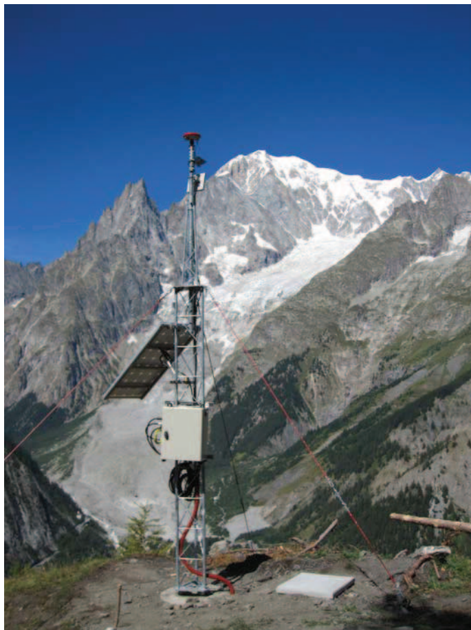
Foto 2: Vista di una delle tre stazioni GPS automatiche in frana.
